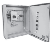
Щит (шкаф) управления типа ЩУВ, стр. 330
