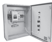
Щит (шкаф) управления типа ЩУВ, стр. 330
