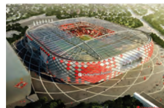
Футбольный стадион «Открытие Арена», г. Москва
