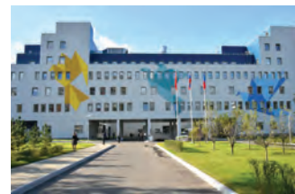
Перинатальный центр, г. Щелково
