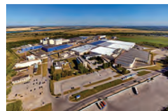
Завод «Проктер энд Гэмбл», г. Новомосковск
