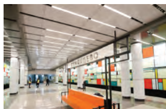
Станция метро «Румянцево», г. Москва
